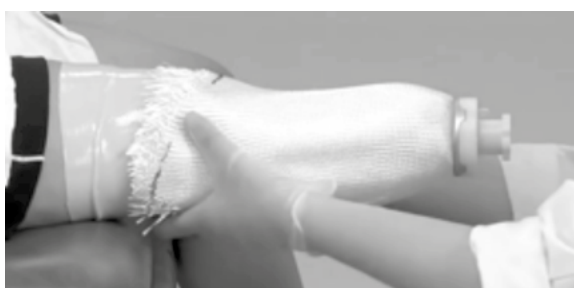
Fig.19 Fissaggio stuoie
