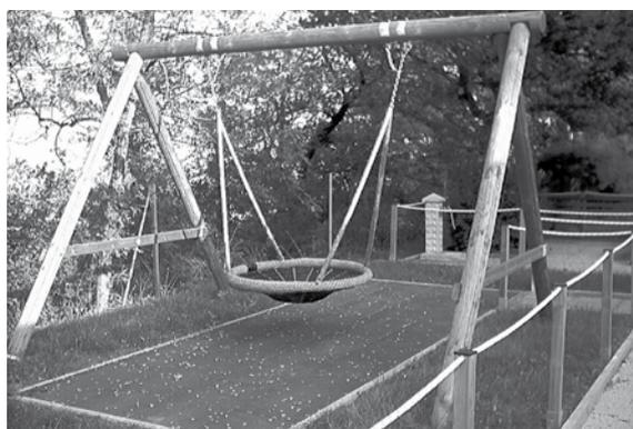
Differenziazione della pavimentazione per segnalare la presenza di un gioco. Le tavole di legno possono essere percepite anche attraverso le ruote della carrozzina - Lega del Filo d'Oro
