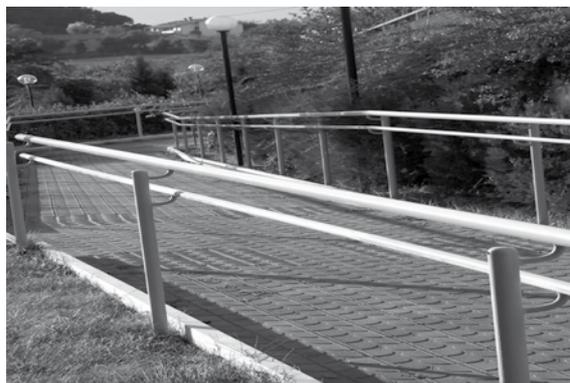
Percorso esterno del Centro di riabilitazione della Lega del Filo d'Oro a Osimo, attrezzato con diversi supporti per facilitare la percorribilità: linee di guida visiva (pavimentazione, cordolo, corrimano, fiori) e linee di guida tattile (cordolo, muretto, doppio corrimano bilaterale) - Lega del Filo d'Oro
