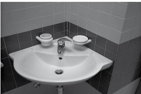
La ceramica scura ha la funzione di linea di guida visiva laterale per facilitare l'orientamento - Lega del Filo d'Oro
